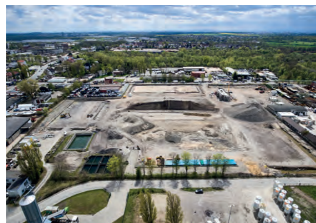
Eine trügerische Ruhe. Unter dem Boden wurden sechs Bomben vermutet, die es zu entschärfen galt.
