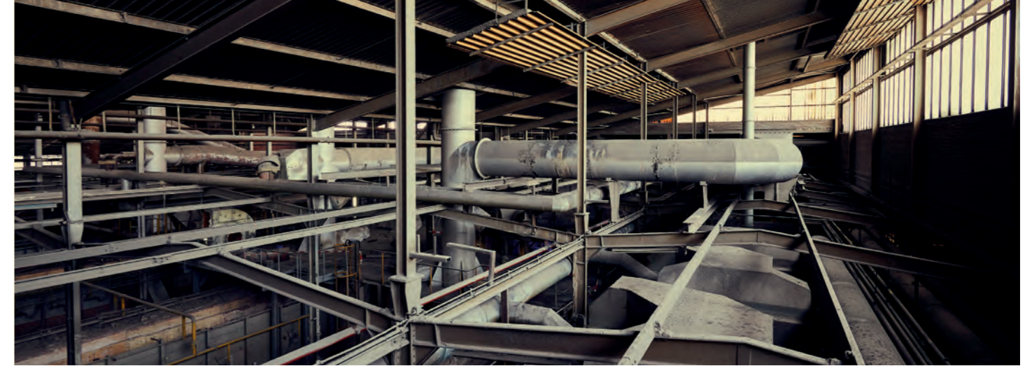
Im Innenraum der ehemaligen Werke finden sich viele Tonnen Stahl. Eine besondere Herausforderung beim Rückbau!
